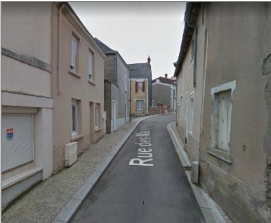
Le Mesnil-en-Vallée : l'aménagement délicat d'une route d'importance enserrée par un front bâti continu
