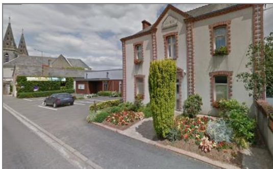
Bourgneuf-en-Mauges : effort d'aménagement paysager sur la mairie
