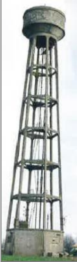
Le château d'eau
