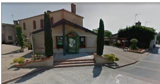
Botz-en-Mauges : la vocation piétonne dans le choix des matériaux, le choix d'une qualité paysagère
