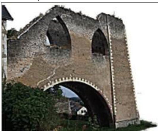
Le chevalement du puits de la tranchée
