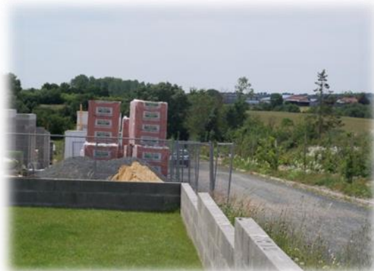
Saint Florent Le Vieil : au loin l'exploitation des Grandes Rabières, qui est le support d'un projet d'installation.
