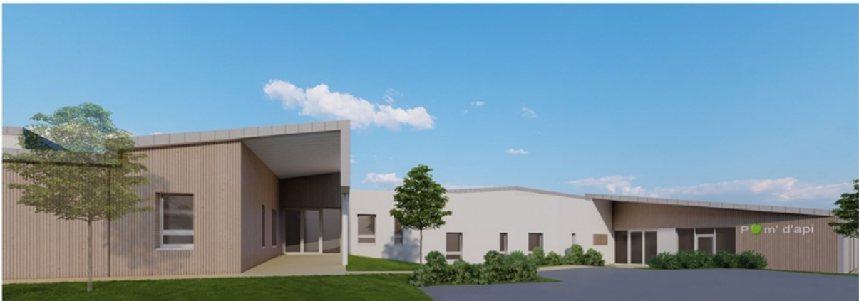
Vue depuis la route de la Blottière
